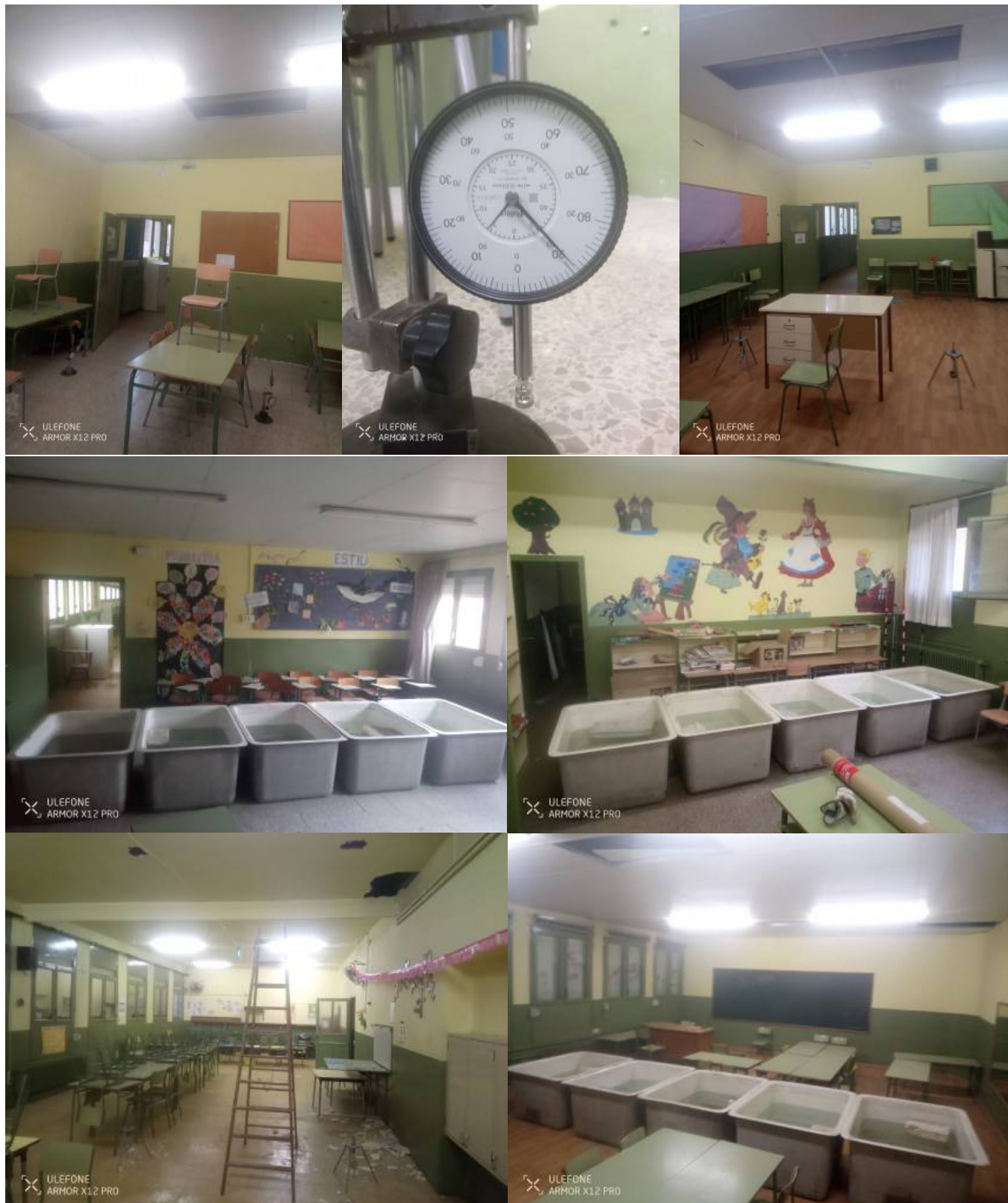
Vista general de las ubicaciones de los comparadores y de los depósitos de las diferentes pruebas de carga
