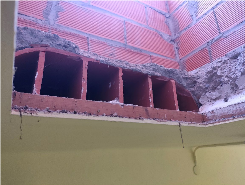
Foto lucernario cubierta edificio 2
