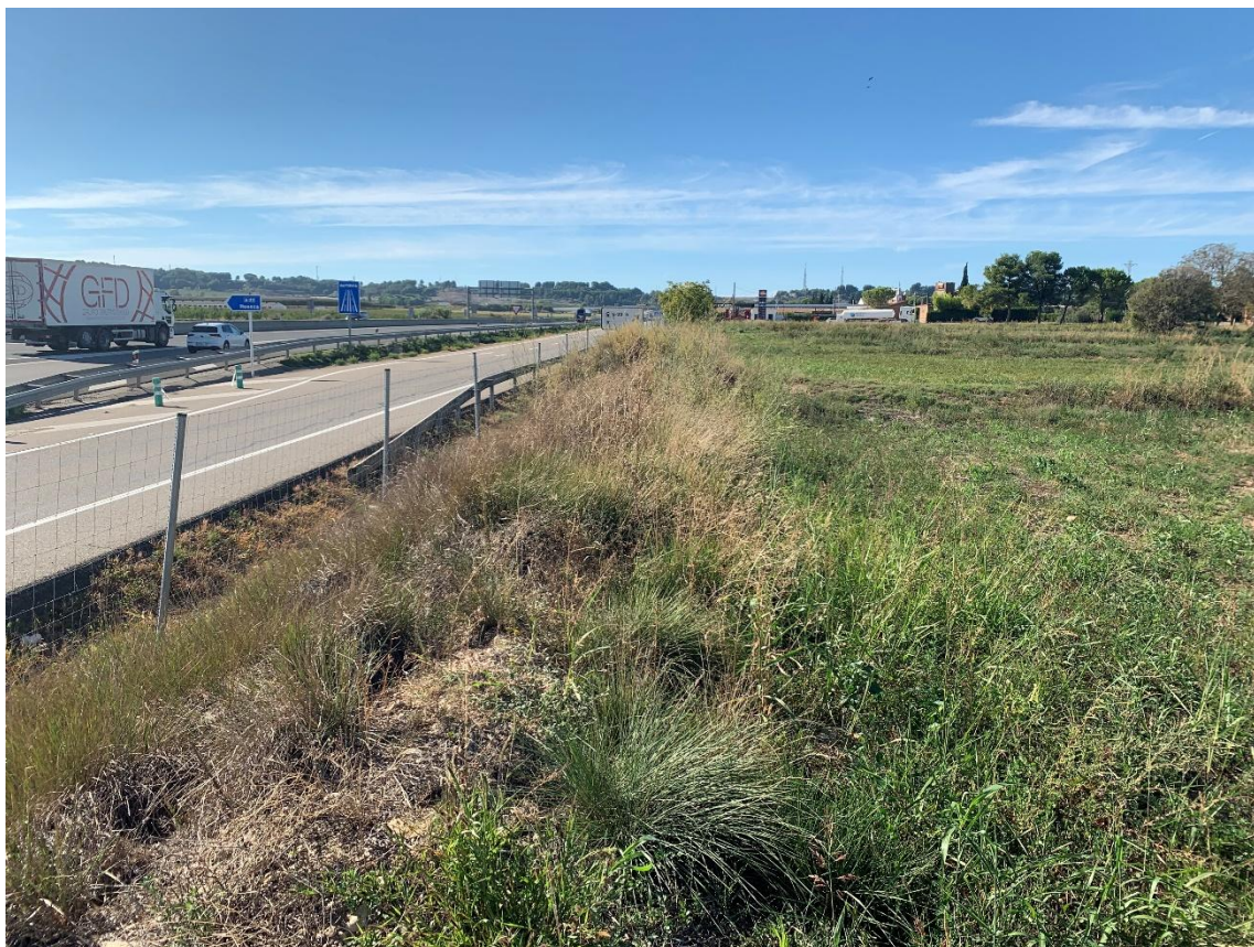
Foto 10. Pas del carril d'acceleració de l'autovia A-22 en límit sud de l'àmbit de la Modificació.
