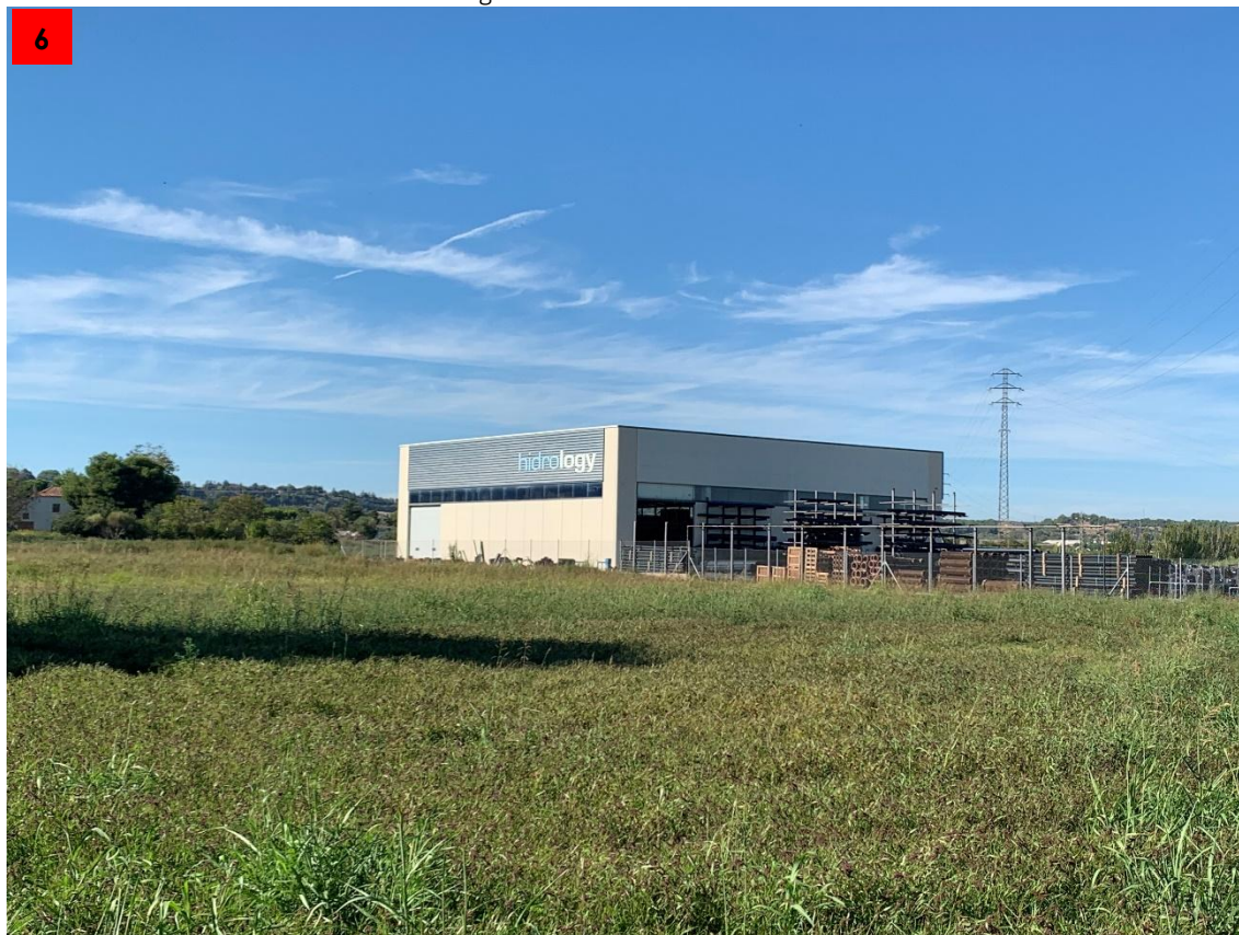
Foto 6. Imatge des de l'extrem sud-est de l'àmbit.
