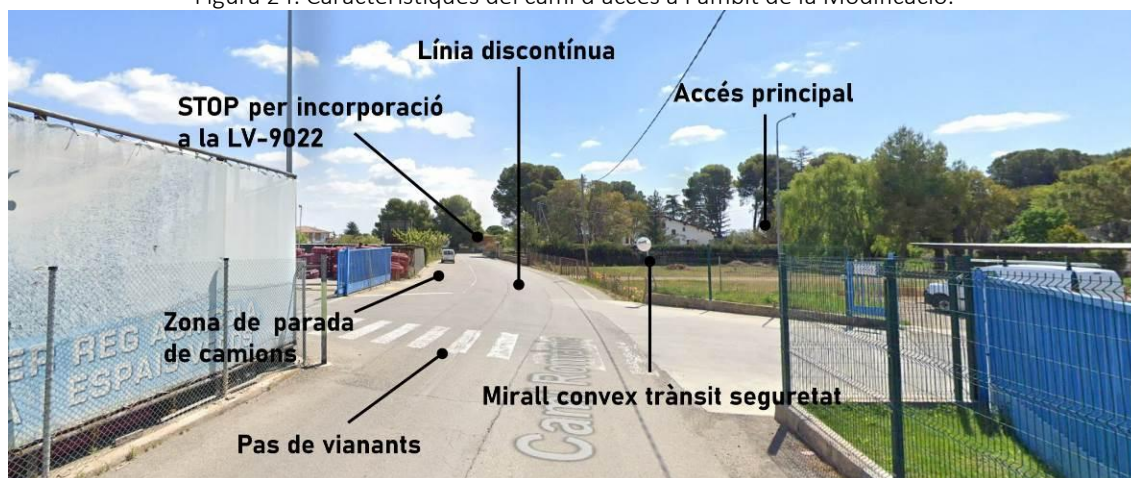
Figura 24. Característiques del camí d'accés a l'àmbit de la Modificació.
