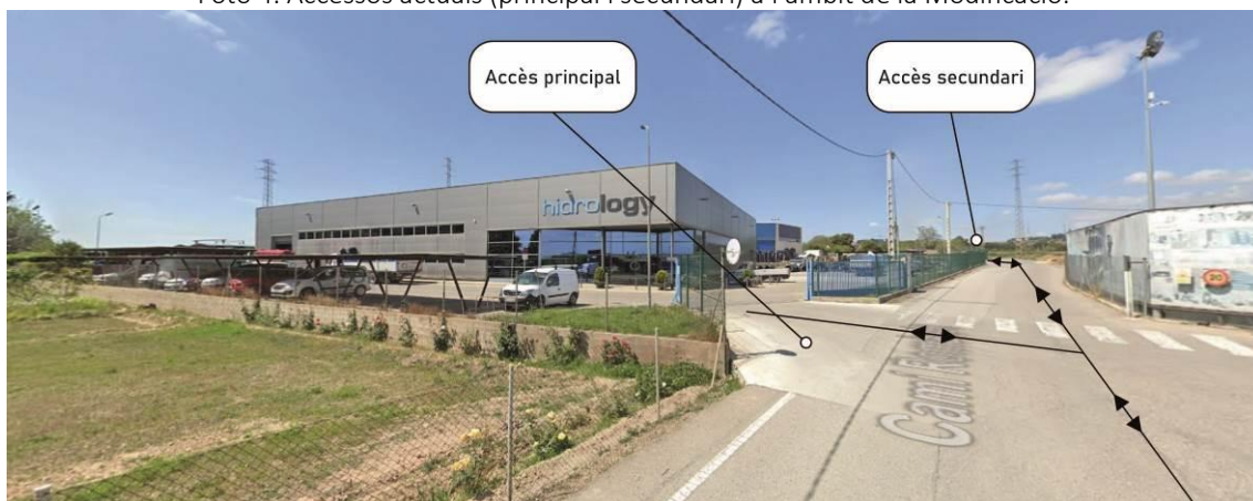
Foto 4. Accessos actuals (principal i secundari) a l'àmbit de la Modificació.
