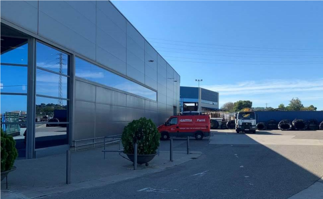
Foto 1. Naus i zona de càrrega i descàrrega, s'observa també la tanca perimetral.
