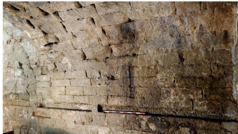
Intradós i paret-estrep oest de la volta núm. 8.
