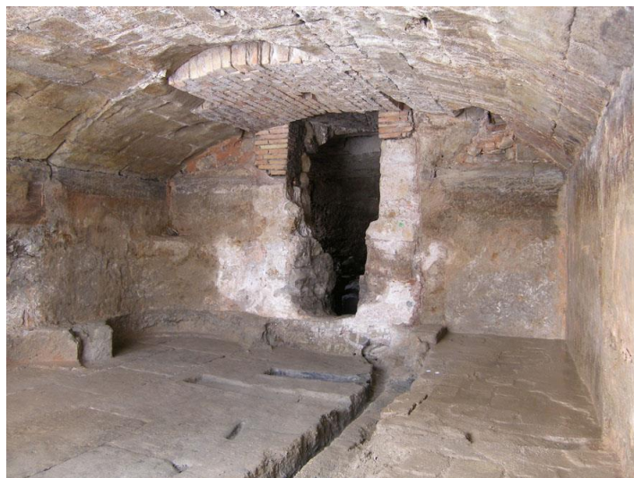
Foto 4: Vista de l'interior del celler amb volta rebaixada de pedra. Observis a la dreta els dipòsits circulars i la paret de tancament corresponent al límit fluvial de la ciutat.
