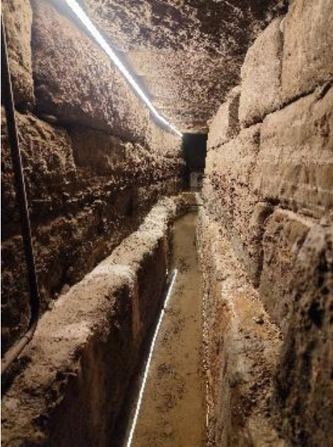
Figura: 12 Vista de la mina/canal de comunicació entre les adoberies 6 i 8 amb el sistema d'il·luminació amb tira LED càlida de baixa intensitat instal·lada l'any 2022.
