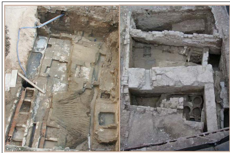
Foto 8: Vista general de les excavacions de la Rambla Ferran 1 (any 2002) i Rambla Ferran 3, 5 i 7 (any 2004) pertanyent a les adobaries número 1,2,3 i 4. Restes parcialment destruïdes i ara cobertes per la llosa de formigó d'un edifici en construcció.
