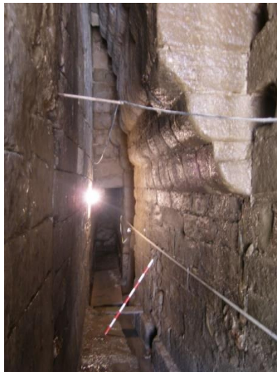
Foto 3: Vista des del sud de l'entrada a la mina de captació d'aigua. Segle XIII
