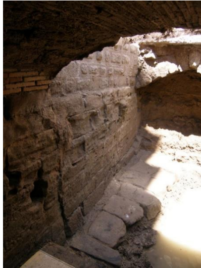
Foto 7: Vista frontal del tancament de la ciutat amb els murs de tancament de les dues adobaries. El de l'esquerra, és l'original del segle XIII i el de la dreta corresponen a la reparació del segle XIV. Observis al fons i utilitzat de fonament els grans blocs de la muralla andalusina (segle X dC).
