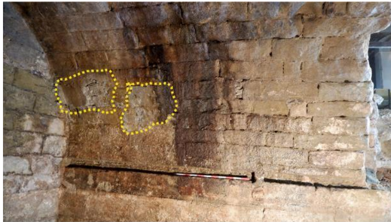
Intradós i paret-estrep est de la volta núm. 8. En línia groga restes de la cisterna encofrada de l'Audiència
