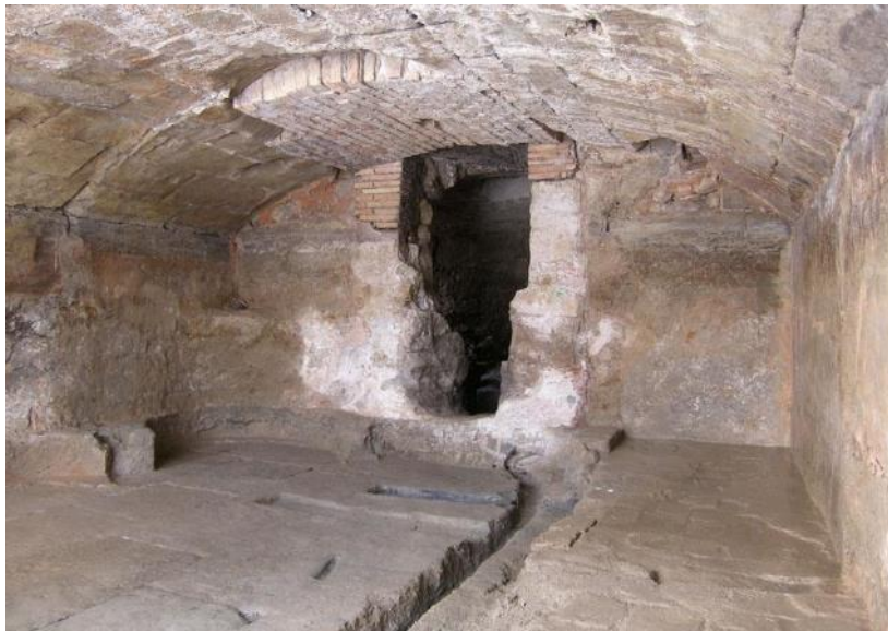
Foto 6: Vista de l'interior del celler amb volta rebaixada de pedra. Observis a la dreta els dipòsits circulars i la paret de tancament corresponent al límit fluvial de la ciutat.
