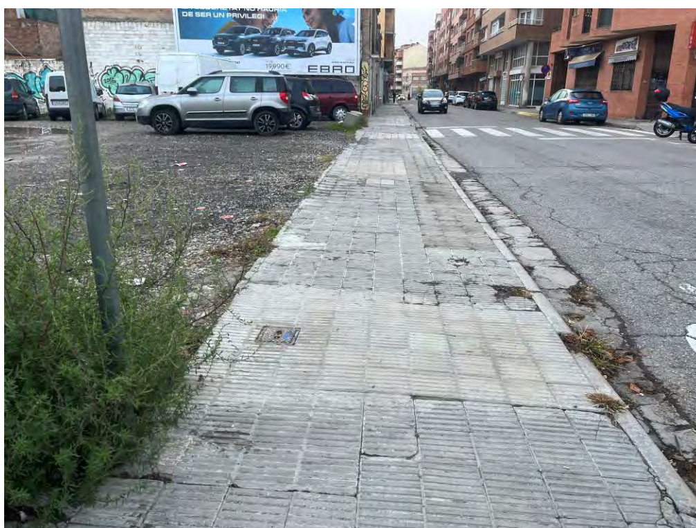
Foto estat inicial carrer Tarragona
