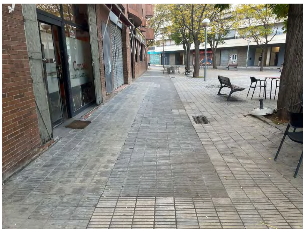
Foto estat inicial carrer Tarragona
