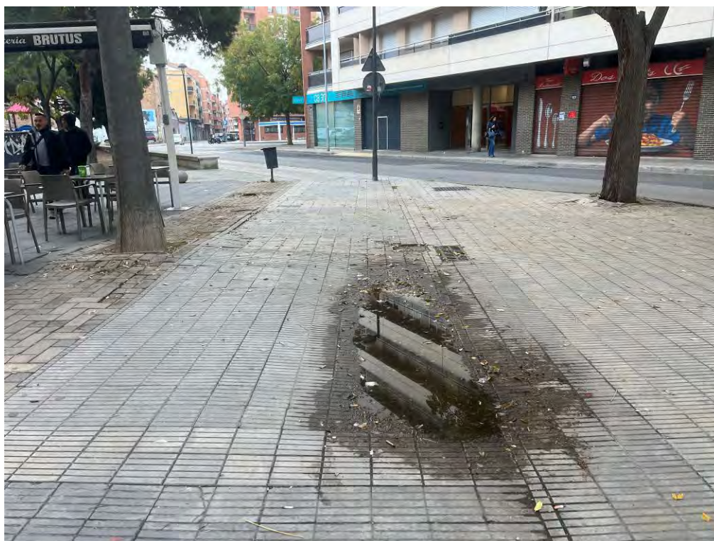
Foto estat inicial carrer Tarragona
