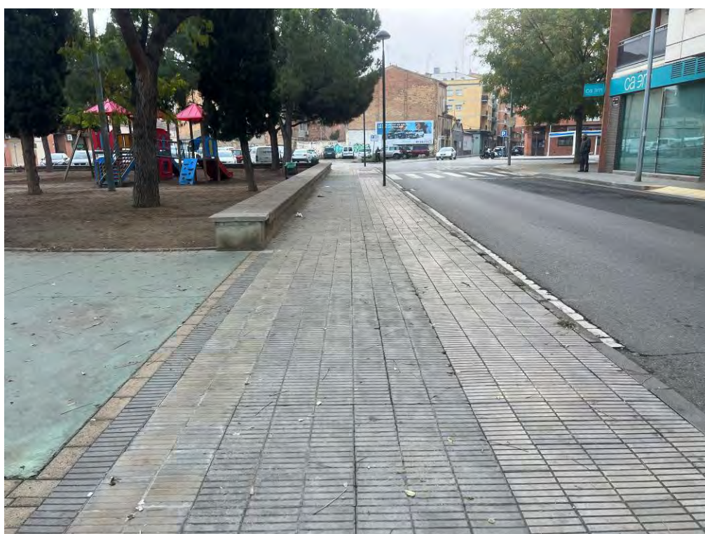
Foto estat inicial carrer Tarragona
