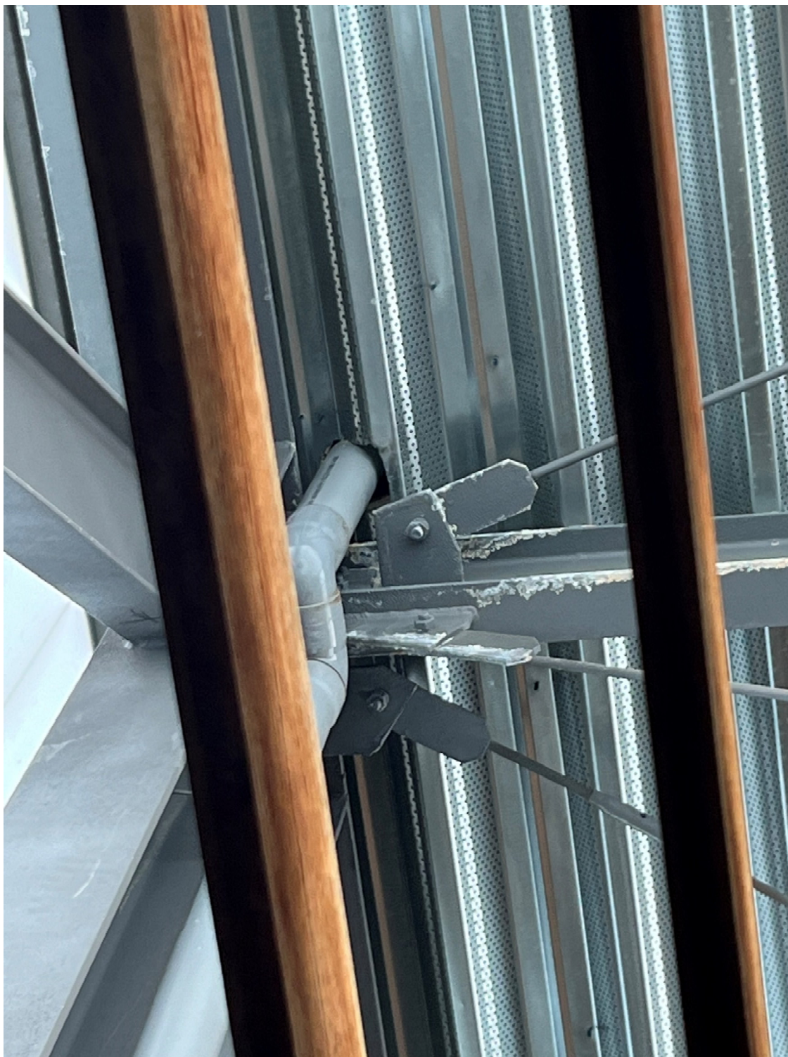
Figura 18: Eflorescències en els perfils
