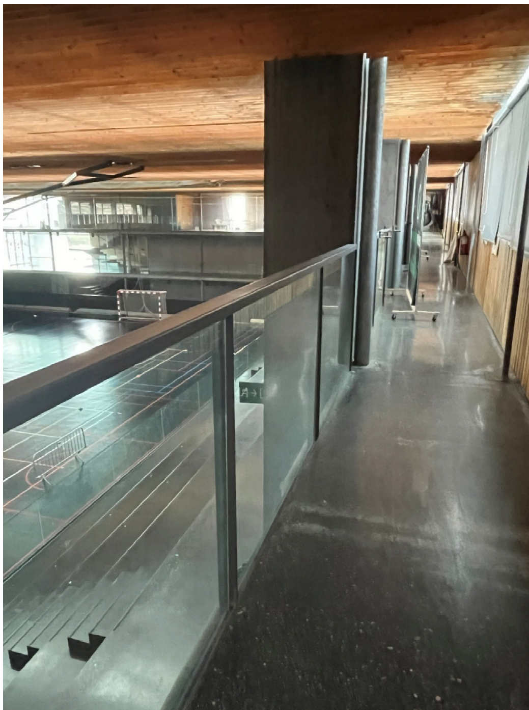
Figura 19: Decoloracions i taques d'eflorescències en els paviments
