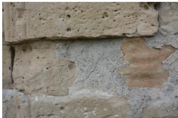
Alguns del morters de reparació que distorsionen la correcta lectura de la portalada.
