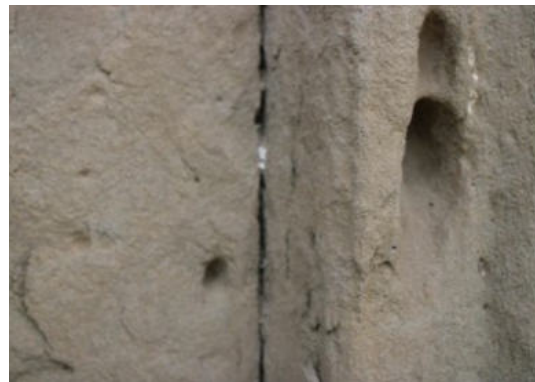
Dos exemples de pèrdua del morter de calç que omplia les fines juntes que uneixen els brancals de la portalada.
