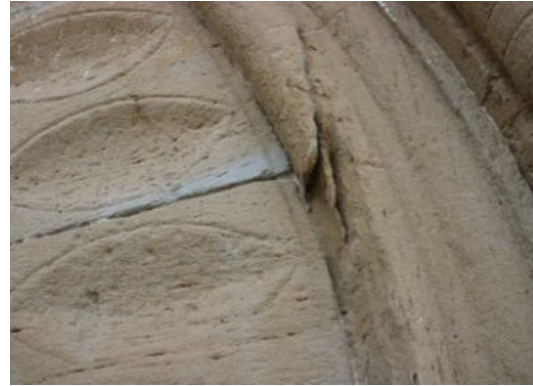
Dos detalls del despreniment de material localitzats a la cantonada d'un carreu que compon el contrafort dret i en la motllura de la tercera arquivolta de la portalada.
