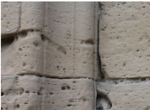
Dos exemples de pèrdua del morter de calç que omplia les fines juntes que uneixen els brancals de la portalada.
