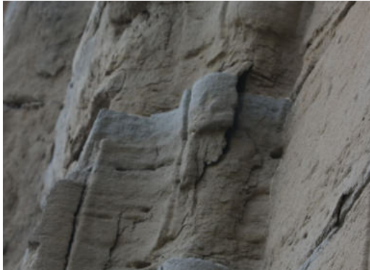
Dos detalls del despreniment de material localitzats a la cantonada d'un carreu que compon el contrafort dret i en la motllura de la tercera arquivolta de la portalada.
