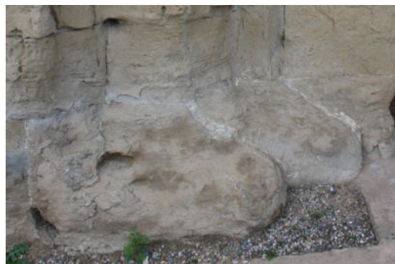
L'avançat procés d'erosió ha deixat grans àrees afectades pel retrocés i pèrdua de suport original.
