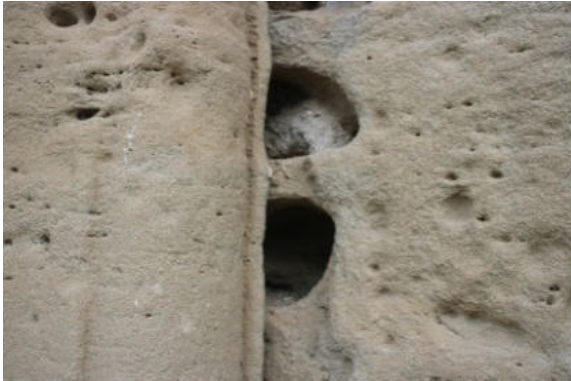
Detall de la formació de cavernes de proporcions reduïdes al brancals de la portalada.
