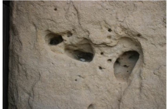
Detall de la formació de cavernes de proporcions reduïdes al brancals de la portalada.
