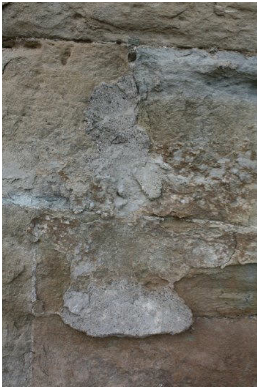
Alguns del morters de reparació que distorsionen la correcta lectura de la portalada.
