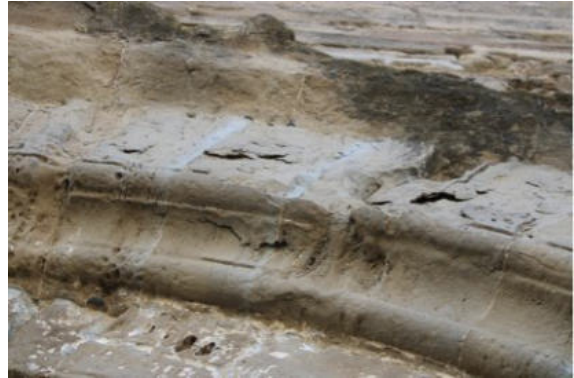
Exemples de descamacions de diferents proporcions als brancals i a les dovelles de la darrera arcuació de la portalada.
