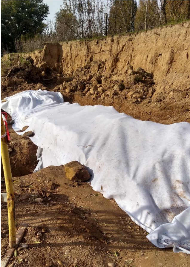
Protecció de les restes amb geotèxtil abans de tornar-les a cobrir de terra.
