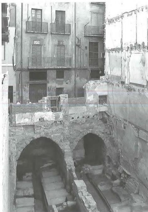
Figura 3. Detall de les voltes exteriors que estructuren a partir dels seus estreps la configuració de les respectives adoberies. (Autor: Secció d'arqueologia. Ajuntament de Lleida)
