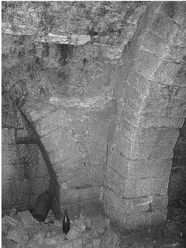
Fig. 19. Detall de la paret nord amb l'arc de descàrrega perimetral i la pilastra d'arrencament de l'arcada perpendicular o diafragmàtica.
