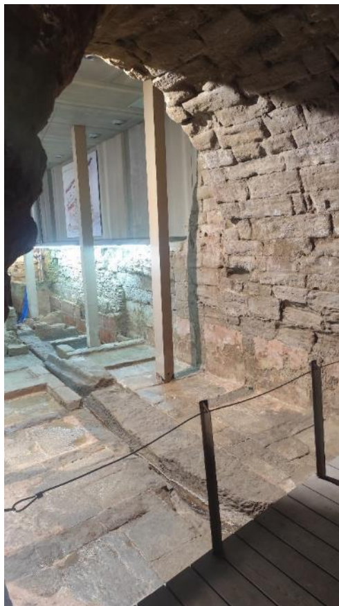
3-Vista de la mina subterrània de captació d'aigua per a les adoberies 5,6 i 7 conservada sota l'edifici del carrer del Carme 10. 4-Detall de la volta de l'adoberia núm. 5.
