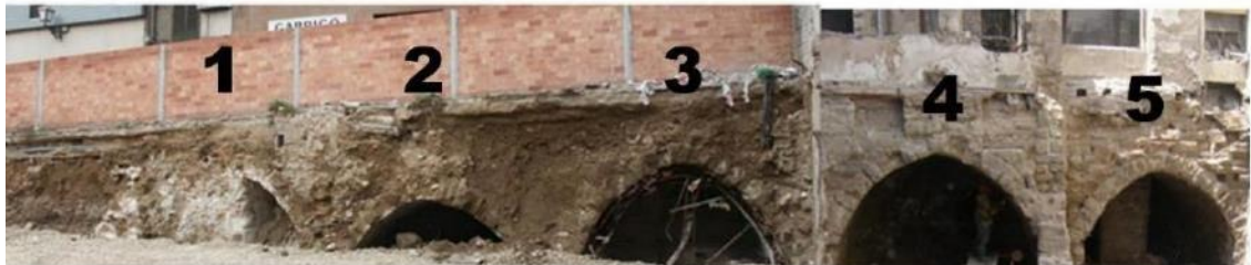
Figura 6: Vista de les cinc primeres voltes de pedra corresponents a les adoberies núm.. 2-6
