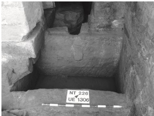
Fig. 37. Vista de la cisterna on s'aprecia el forat del canal d'entrada de l'aigua tapiat. S'observa darrere el canal de la mina.
