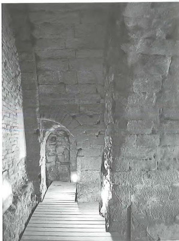
Figura 4. Detall dels passos oberts en els estreps de les voltes interiors del criptopòrtic que permet als adobers accedir a les seves adoberies. En aquest cas, en primer terme el pas entre l'adoberia 5 i 6 i al fons porta tapiada d'accés a l'adoberia 7 encara per descobrir. (Autor: Secció d'arqueologia. Ajuntament de Lleida)
