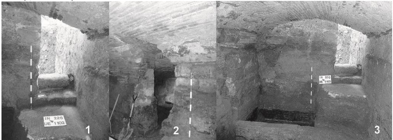
Fig. 82. 1. Detall de la porta d'entrada al nou soterrani; 2. Detall de l'obertura de pas entre els dos soterranis i l'encaix de les dues voltes; 3. Vista general de l'interior amb el mur de tancament nord al fons i en primer terme la caixa de fusta.
