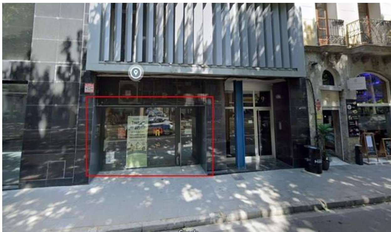
1- Vista de l'accés a les adoberies 5 i 6 conservades i museïtzades a la planta baixa de la rambla Ferran 9.
