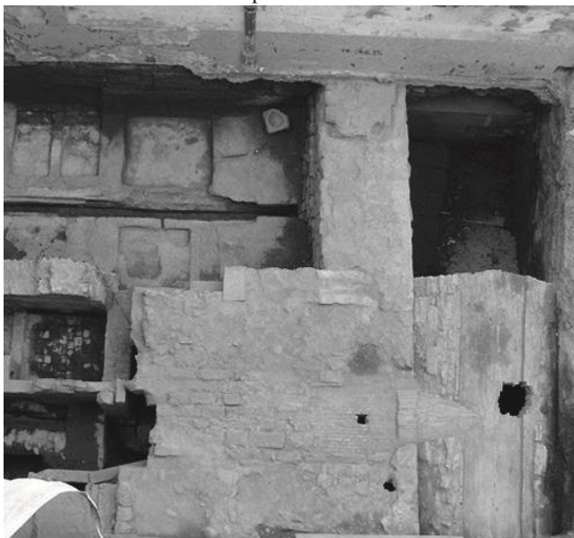
Fig. 83. Vista general de l'extradós de les voltes pertanyents als soterranis operatius en aquesta fase. Volta de pedra u.e.: 1127 fase II i volta de maons (u.e.: 1106 fase X), a l'esquerra de la imatge.
