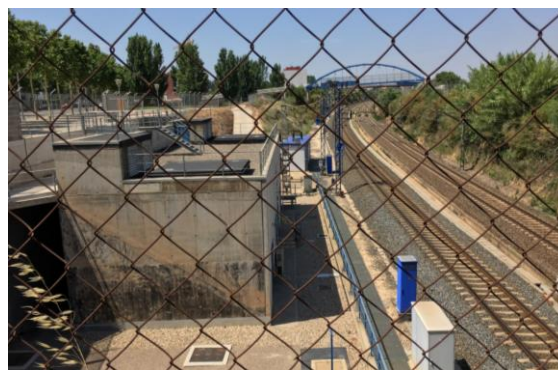
Vista des de la sortida del túnel cap a l'oest.
