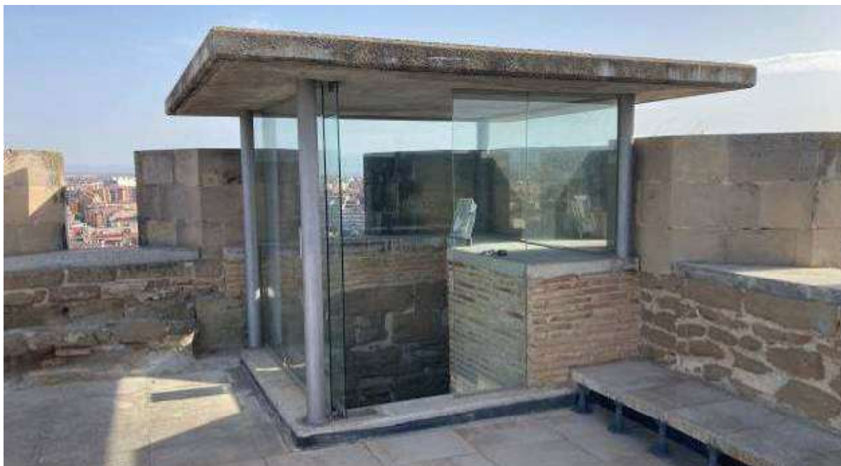
Badalot de sortida a la coberta plana de la torre
