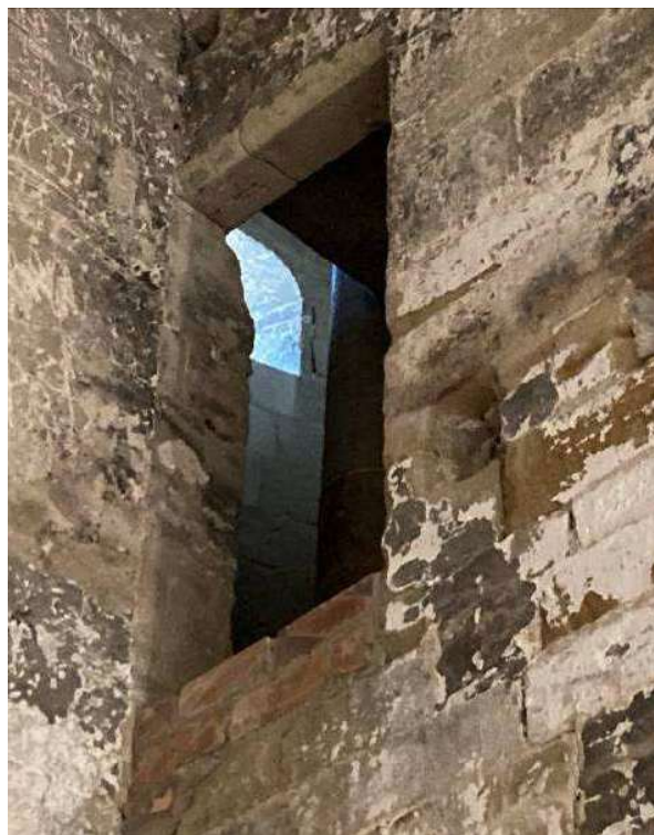
Finestra façana oest / Obertura anulada d'antic accés a les escales de cargol embegudes en la façana nord
