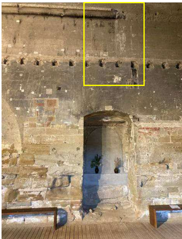
Afectació agressiva dels excrements de coloms sobre els la part interior de la façana nord
