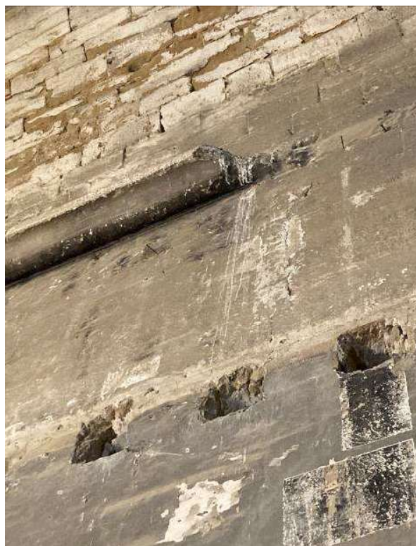
Afectació agressiva dels excrements de coloms sobre els la part interior de la façana nord
