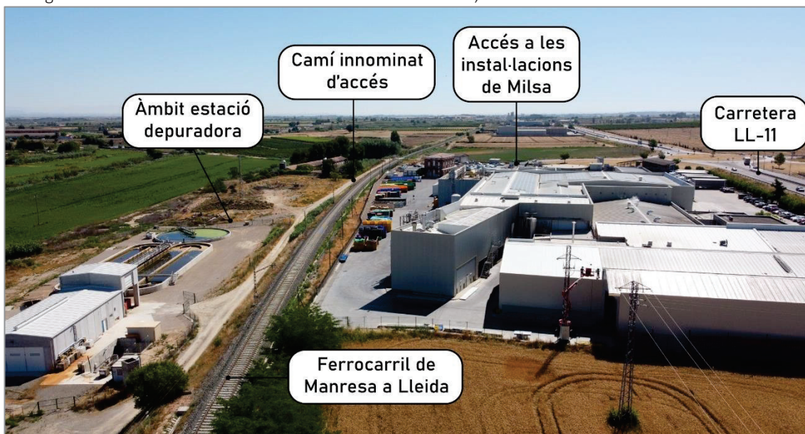
Fotografia 6. Pas de la línia de ferrocarril de Manresa a Lleida, entre l'àmbit nord i sud de la Modificació.
