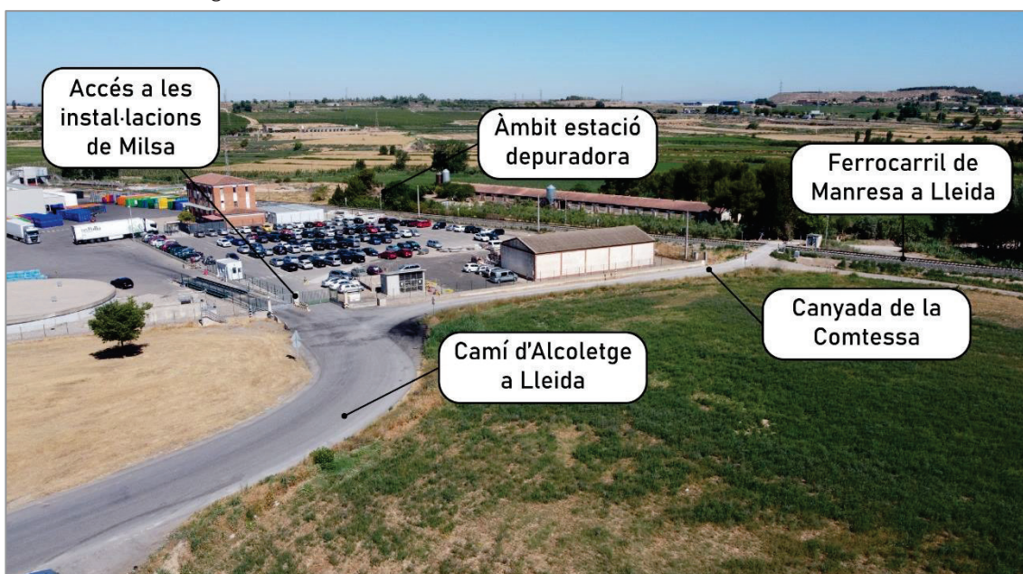
Fotografia 5. Accés a l'àmbit sud des de la rotonda de la carretera LL-11.
