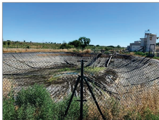
Fotografia 12. Basses d'emmagatzematge d'aigua buides.
