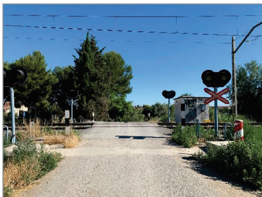
Fotografia 11. Zona de pas a nivell de la xarxa ferroviària R12.
