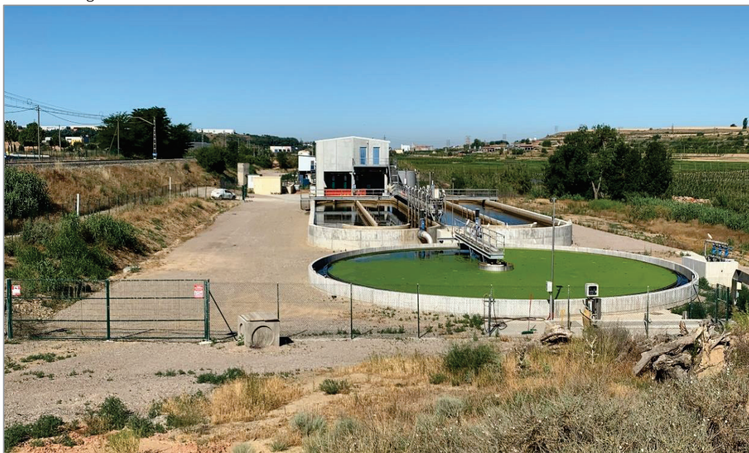
Fotografia 2. Instal·lacions de l'EDAR i edificacions aïllades al nord de la xarxa ferroviària.
