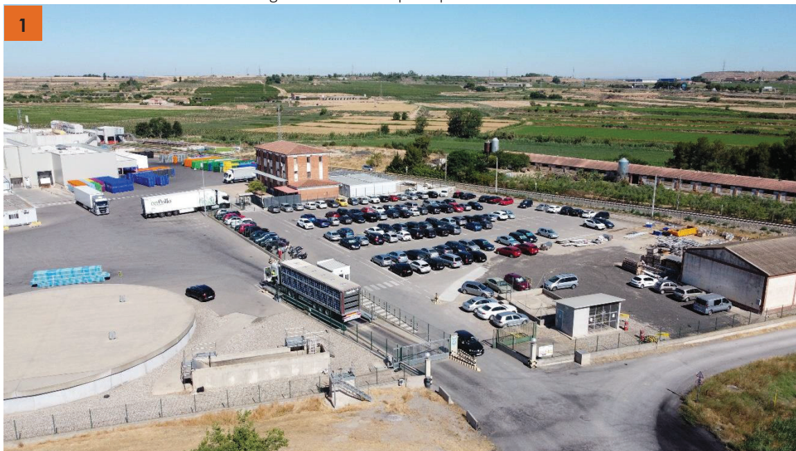
Foto 1. Imatge des de l'accés principal a l'àmbit d'activitat.
