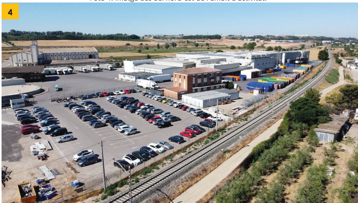
Foto 4. Imatge des del nord-est de l'àmbit d'activitat.
