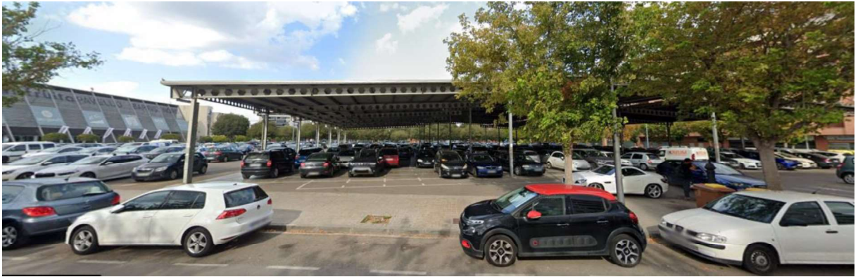
Vista de l'aparcament des del carrer del Baró de Maials.
