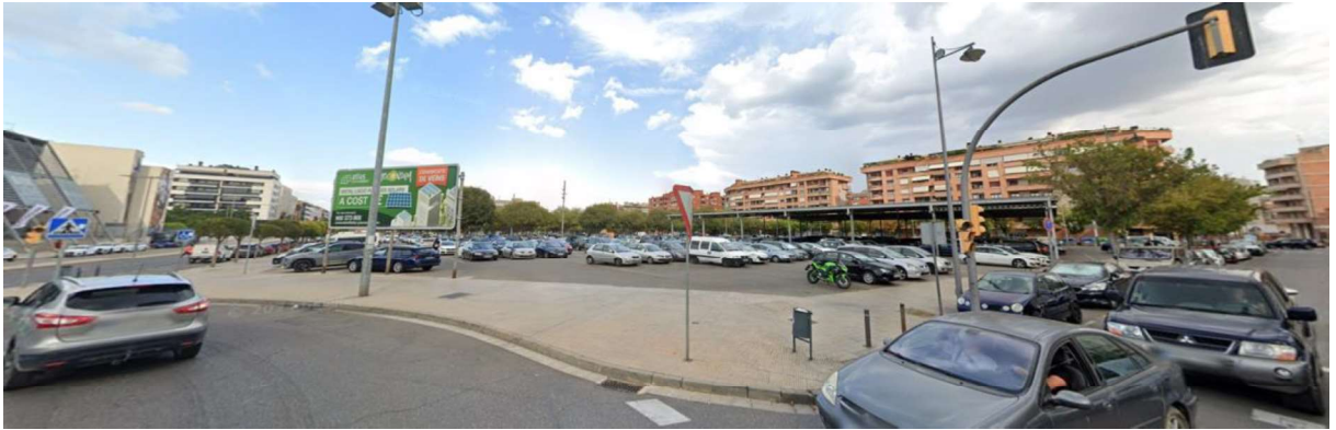
Vista general des de l'oest, confluència entre l'av. Prat de la Riba i el carrer del Baró de Maials.
