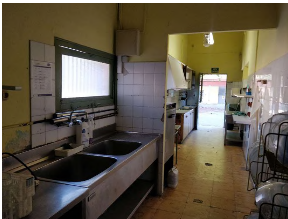
Fotografia 23_ Vista zona cuina.
