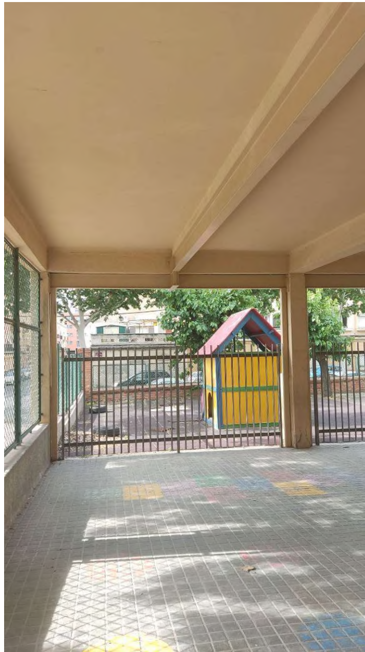
Fotografia 09_ Vista del porxo a la banda est, amb reforços trencallums
