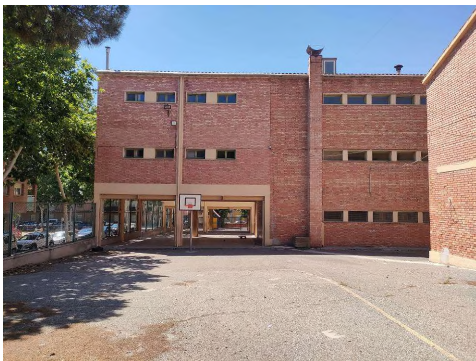
Fotografia 31_ Zona del tester edifici 3, amb vista dels porxos dels edificis 1 i 2.
