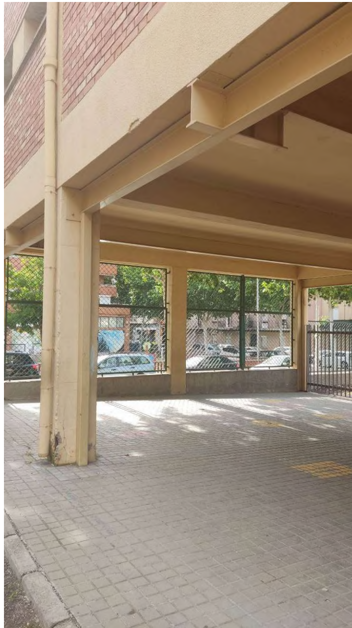
Fotografia 11_ Vista del porxo amb reforços metàl·lics.
