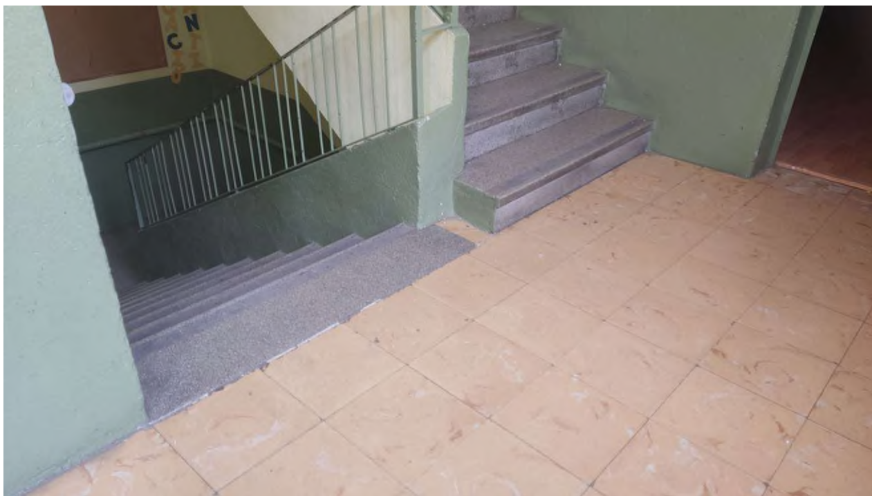
Fotografia 07_ Vista de les escales existents.
