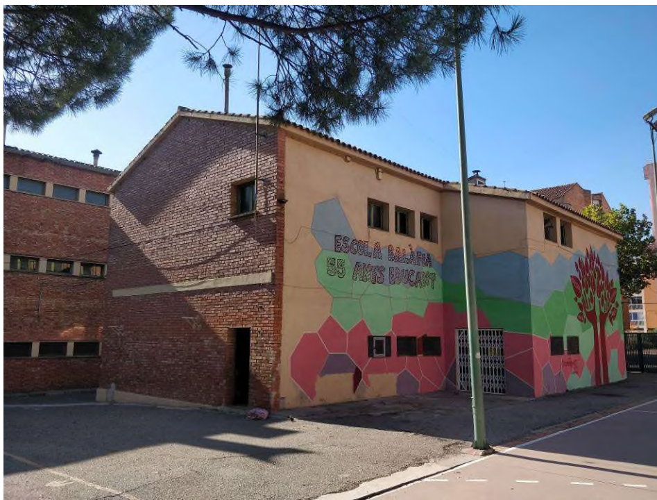
Fotografia 18_ Vista façana cantonada nord-est.
