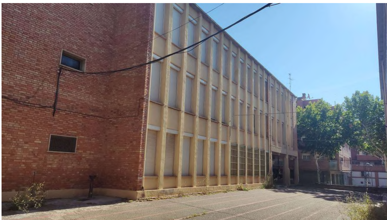
Fotografia 13_ Vista façana sud.
