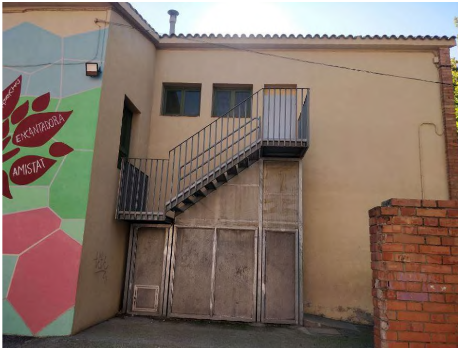
Fotografia 20_ Vista escala metàl·lica façana nord.
