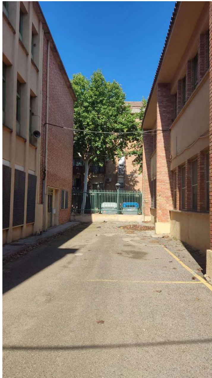
Fotografia 29_ Vista pati entre edifici 2 i 3.
