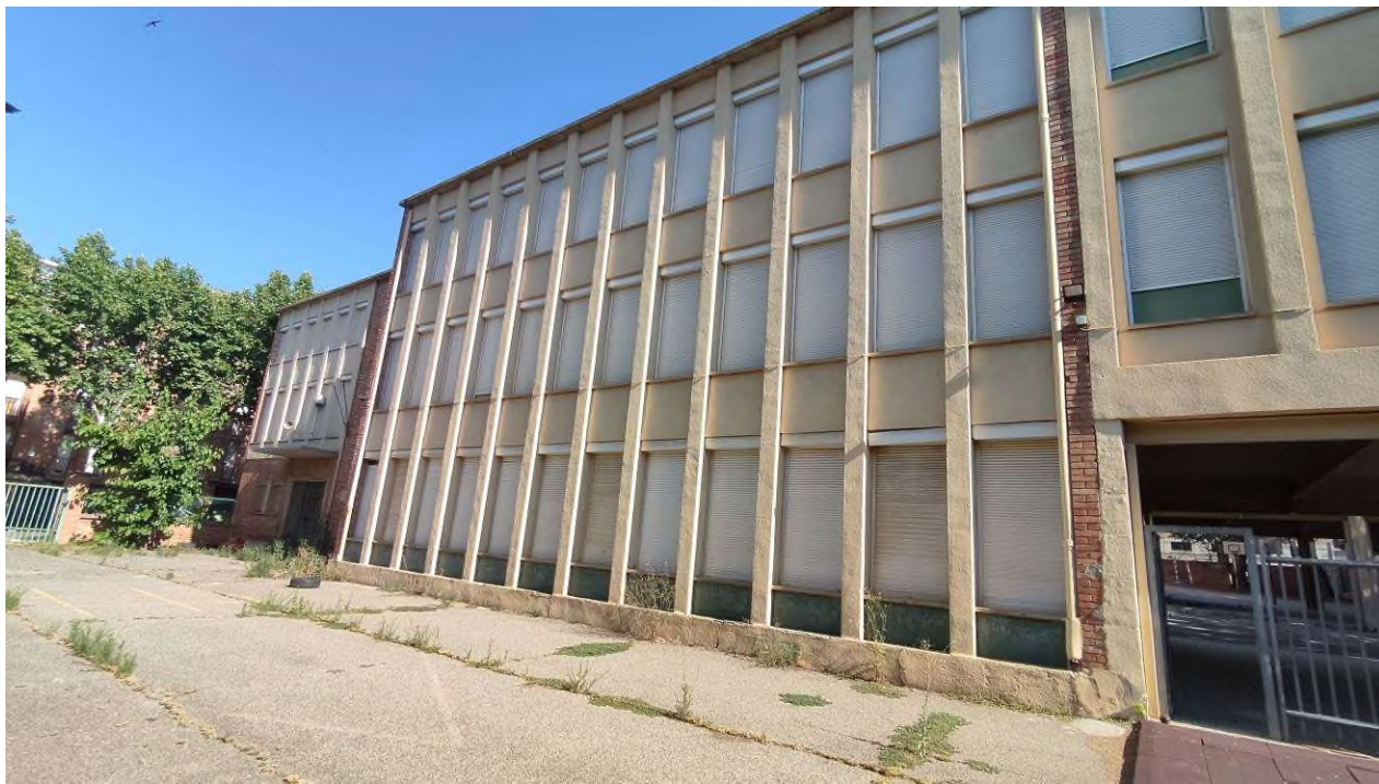
Fotografia 01_ Vista façana sud.
