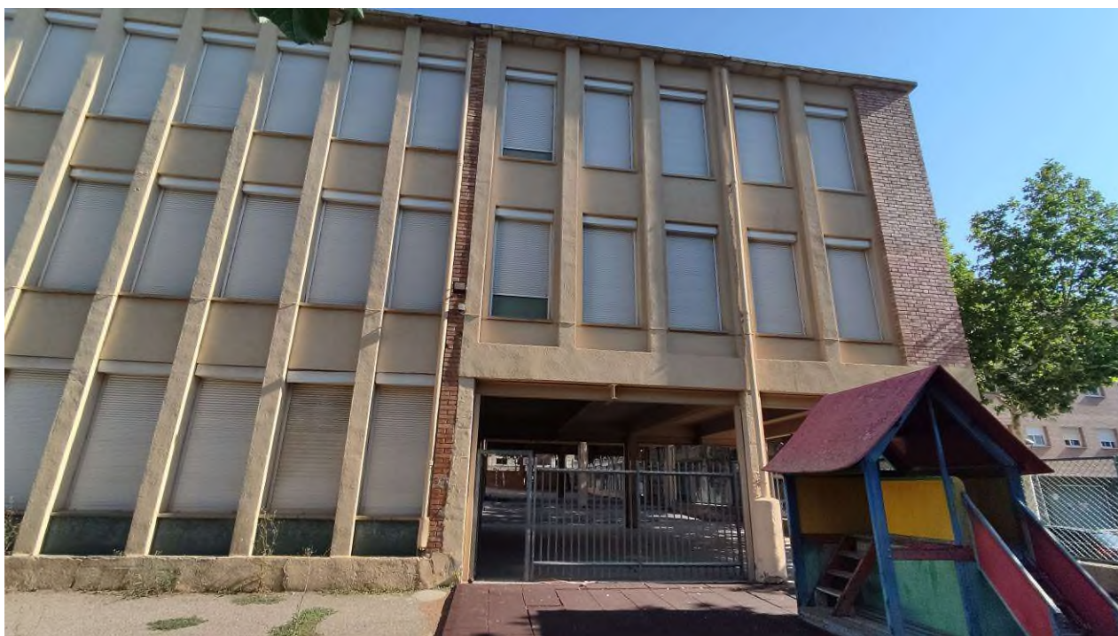
Fotografia 02_ Vista façana sud.
