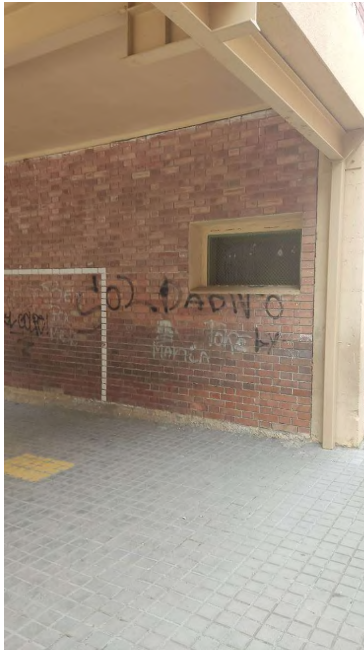
Fotografia 10_ Vista del porxo amb reforços metàl·lics.
