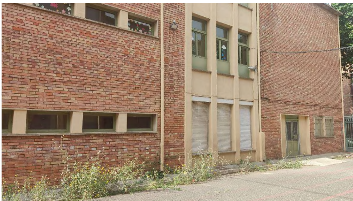
Fotografia 04_ Vista façana nord, banda oest, amb l'accés actual.
