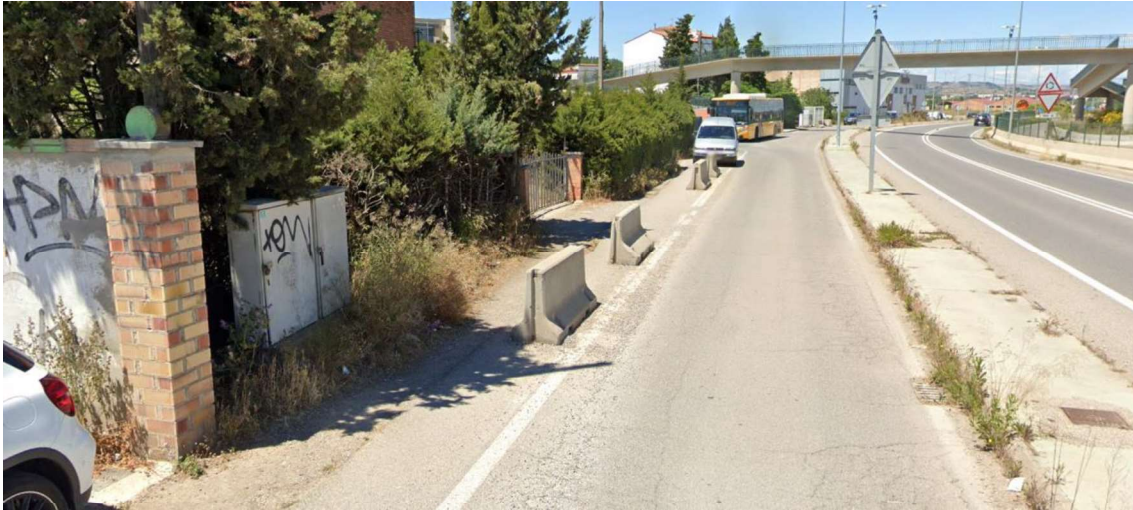
Foto 4. Delimitació provisional per a vianants en la voravia de la N-230, entorn de l'Escola St. Jordi i IES Manuel de Montsuar.
