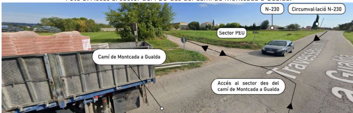
Foto 3. Accés al sector del PEU des del Camí de Montcada a Gualda.
