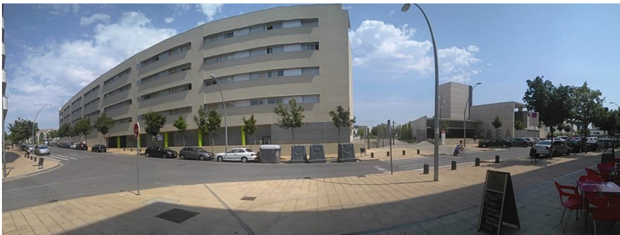
Vista de la façana dels edificis Universitaris existents al carrer Pere Cabrera
