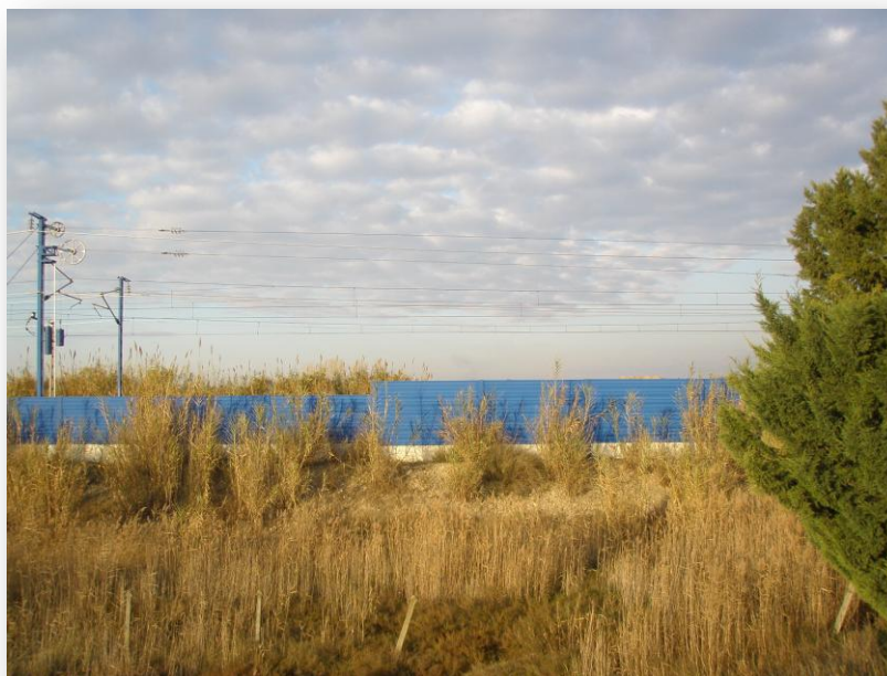
Figura 22: Vista de la línia del T.A.V. des de la residència
