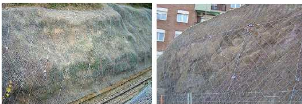
Figures 6 i 7. Exemples de protecció amb xarxes metàl·liques i cables ancorats amb piquetes al terreny.
