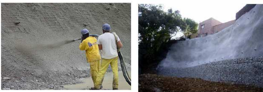
Figures 8 i 9. Protecció de amb formigó projectat sobre malla metàl·lica clavada i amb mur de rocalla al peu del talús.
