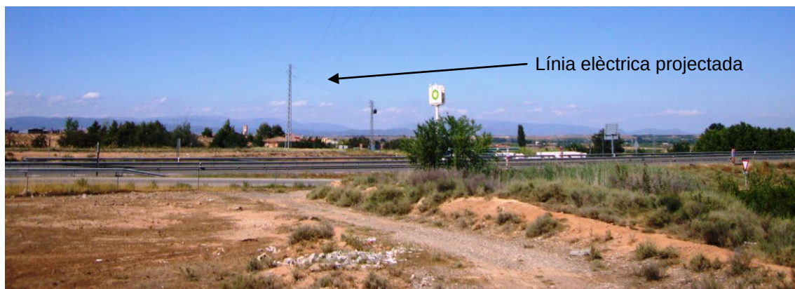
Imatge 2: Vista panoràmica de la línia elèctrica projectada i el seu entorn, al seu pas per l'autovia A2.
