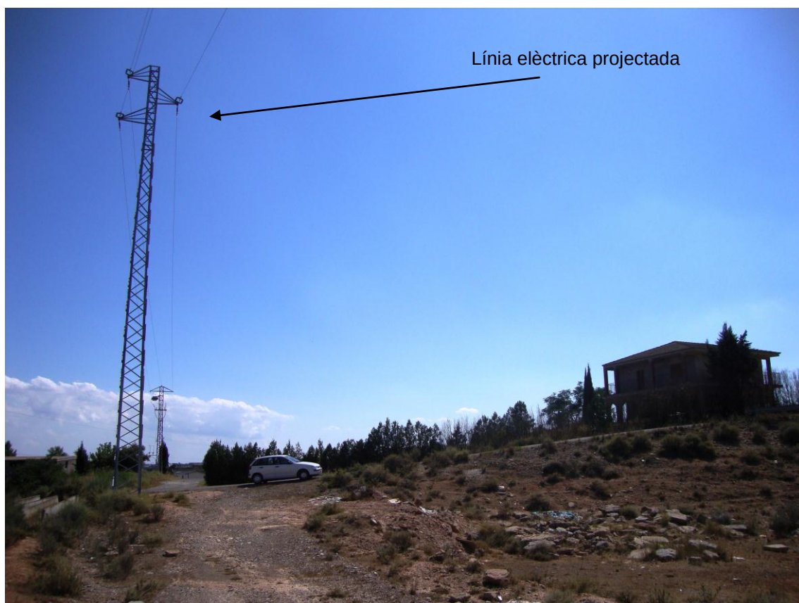
Imatge 5: Vista de la línia elèctrica projectada i el seu entorn.
