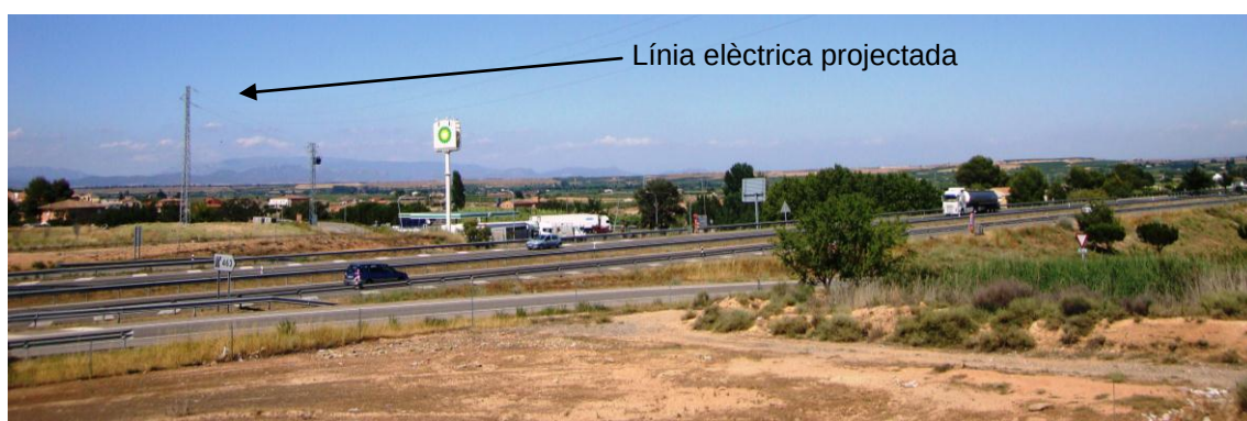
Imatge 3: Vista panoràmica de la línia elèctrica projectada i el seu entorn, al seu pas per l'autovia A2.
