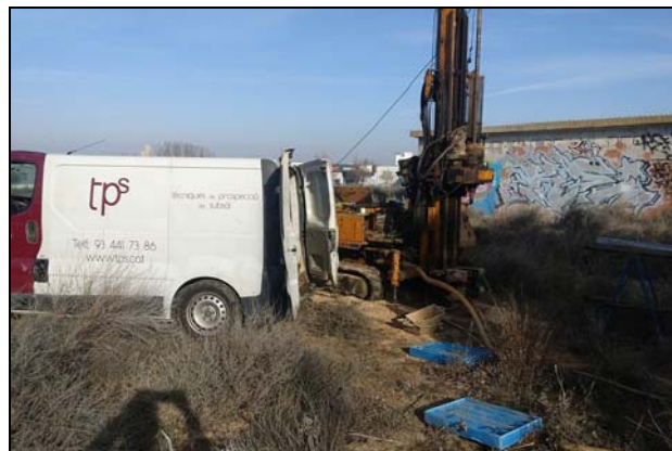
Fotografia 3. Vista de la màquina utilitzada per a la realització del sondeig a rotació S-1.
