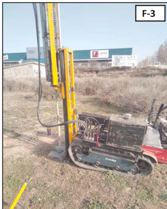
Fotografia 3: Detall de l'emplaçament de la màquina realitzant l'assaig de penetració dinàmica DPSH P-2.
