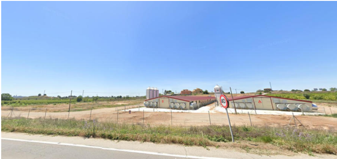
Imatge presa des del punt E . Conca visual direcció Oest. Font: Google maps.
