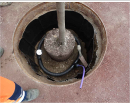
RootRain Urban con el goteo dentro y ReRoot anti raíces.
