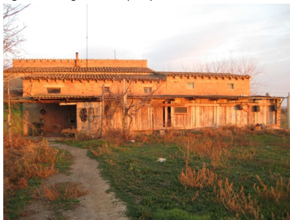
Figura 9. Fotografia de la part posterior de l'edificació.
