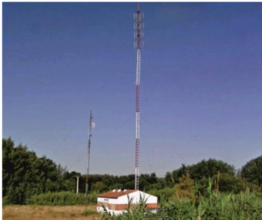
Vista Cercana. Estado Actual.
