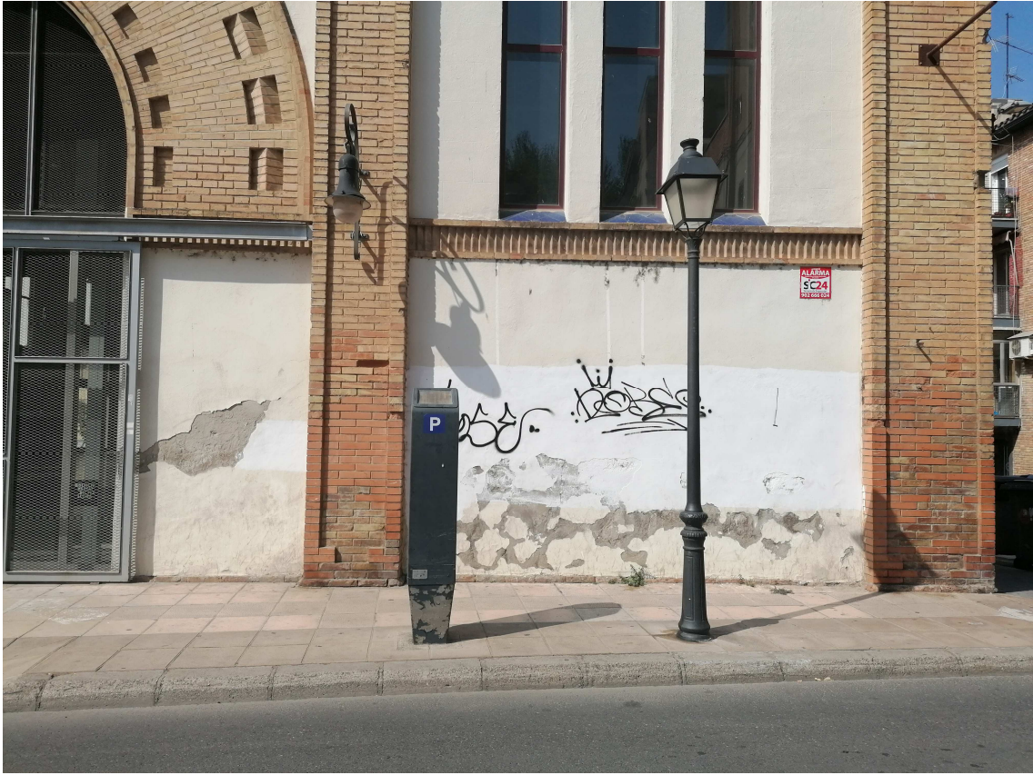
Fotografia 03_ Detall escrostonament façana c/ Sant Martí.
