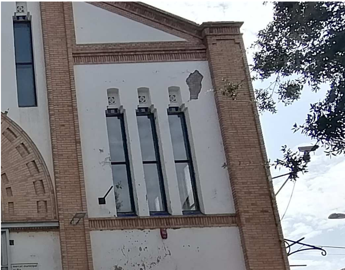
Fotografia 06_ Detall escrostonament façana, plaça dels Gramàtics.
