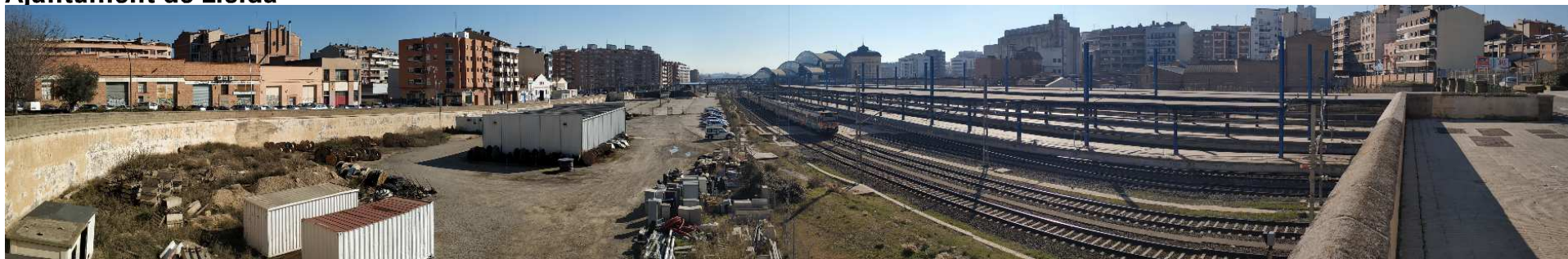
Vista cap al sud del PE 3 des del carrer Comtes d'Urgell
