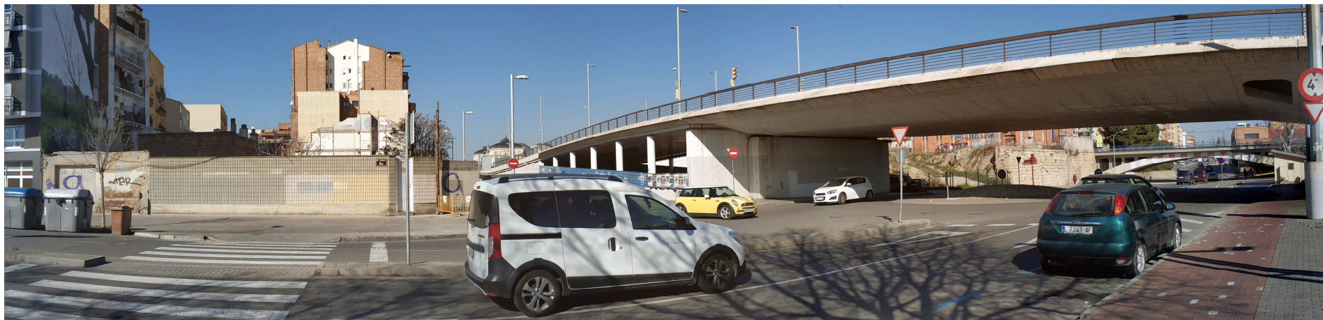
Vista sud-est PE 3
