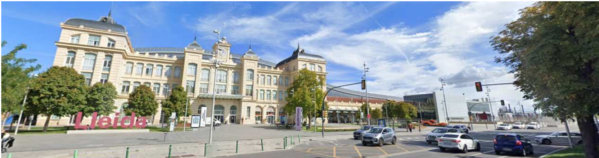
Vista estació de viatgers
