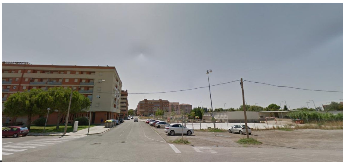
Projecte de construcció de nova vorera al C/Valls d'Andorra, entre el C/Gandhi i Avda. de Pinyana.
