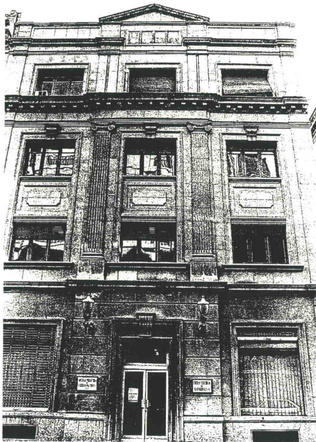
Façana des de Blondel.
