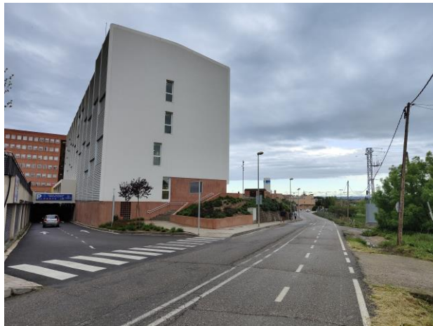
V5. Carrer Arquitecte Maria Goma_Acces Aparcament soterrat_Edifici EPH1
