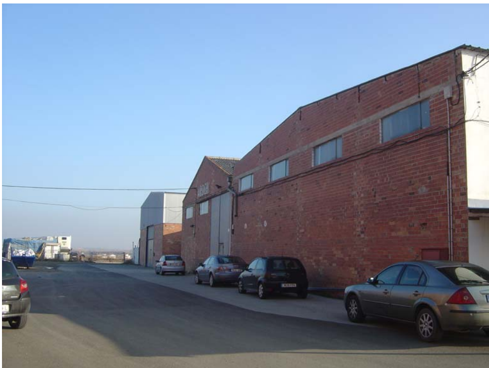
Foto núm. 2.- Vista transversal edificacions existents.
