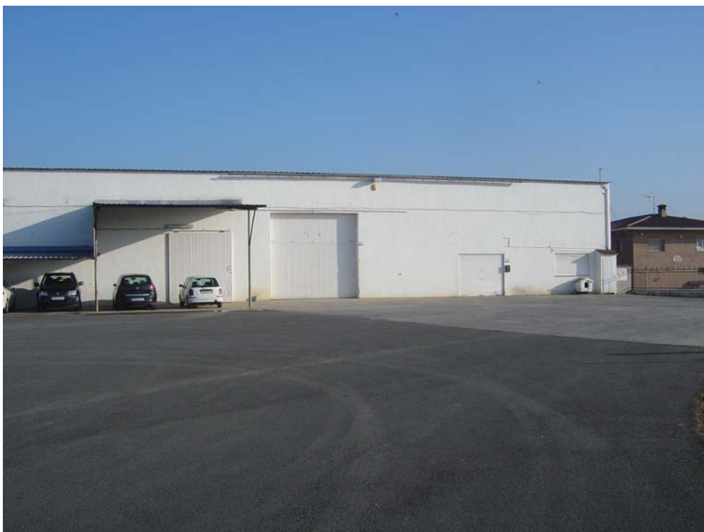
Foto núm. 1.- Vista longitudinal edificacions existents.
