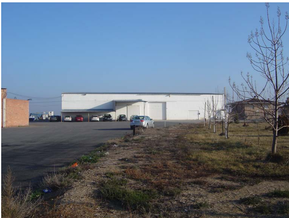
Foto núm. 10.- Vista general Sud-Nord.
