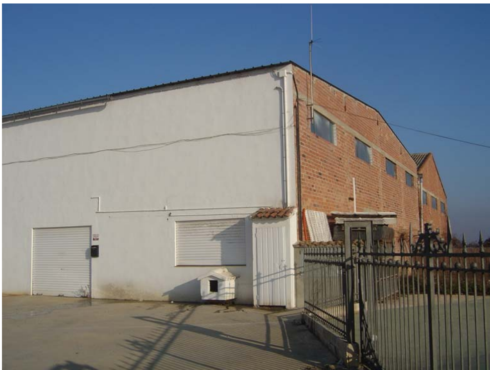
Foto núm. 3.- Vista transversal posterior edificacions existents.
