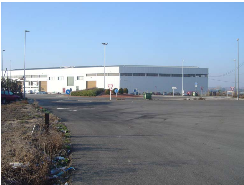
Foto núm. 7.- Vista general rotonda d'accés des de la carretera Lleida-Vielha.
