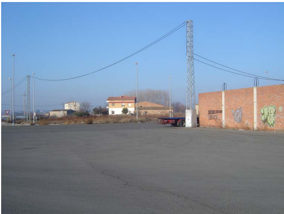
Foto núm. 8.- Vista Oest.
