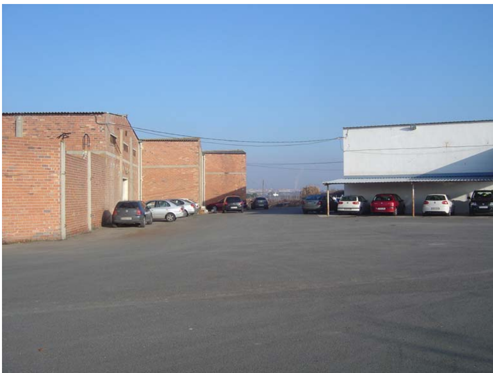
Foto núm. 9.- Vista lateral, edificacions col·lindants existents.
