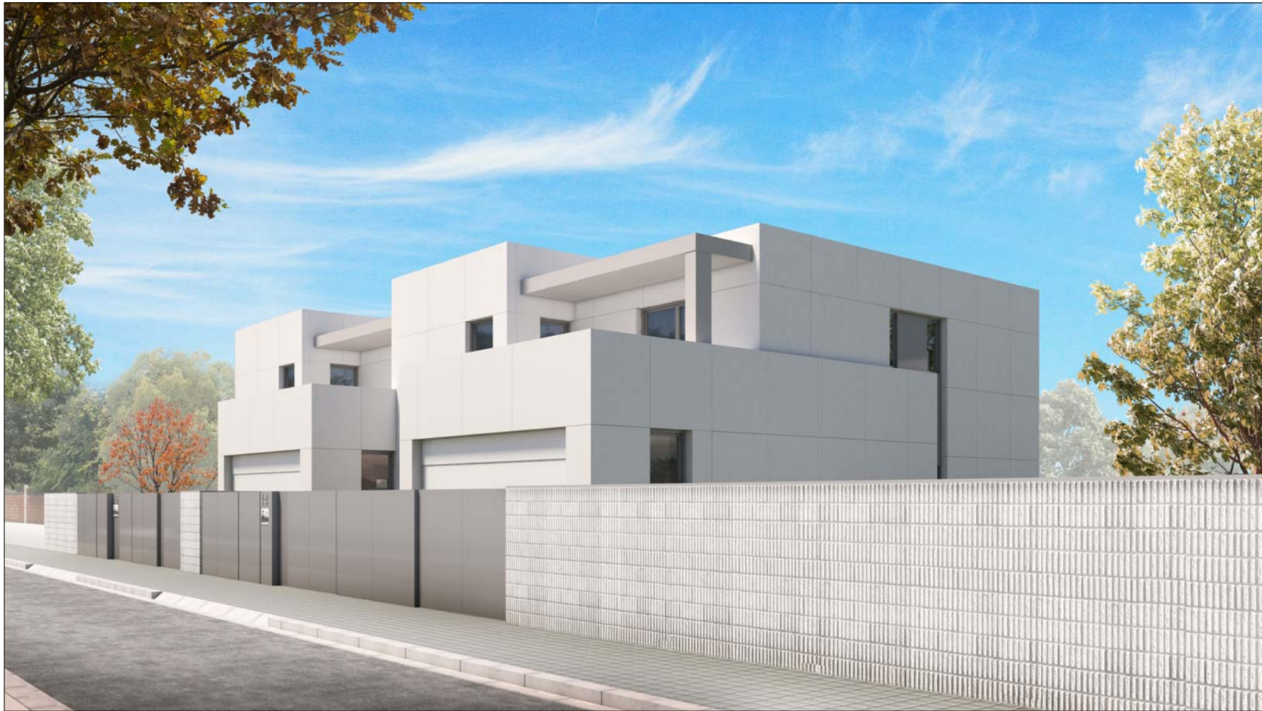
IMATGE 1 HABITATGES APARELLATS. FAÇANA PRINCIPAL
