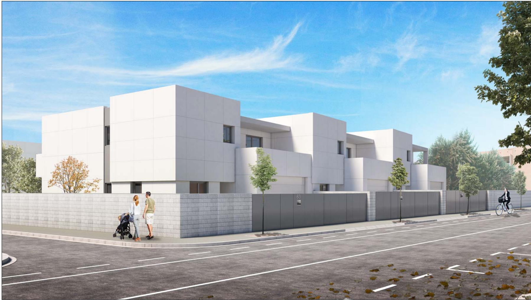
IMATGE 2 HABITATGES EN FILERA. FAÇANA PRINCIPAL
