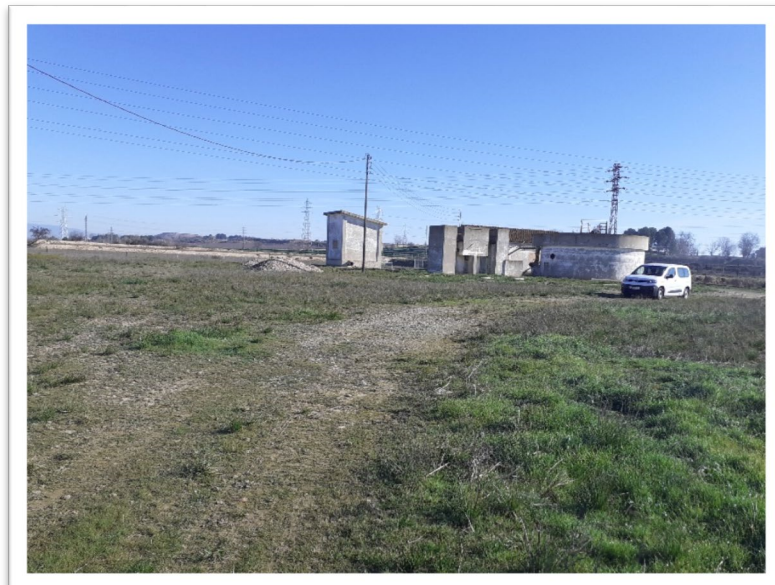
FOTOGRAFIA NÚM. 7. ANTIGUES INSTAL·LACIONS PLANTA TRACTAMENT
