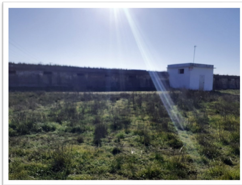
FOTOGRAFIA NÚM. 5. UBICACIÓ ESTACIÓ FILTRATGE
