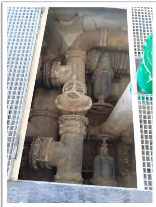
FOTOGRAFIA 1 CONDUCCIONS D'ENTRADA I SORTIDA DIPÒSIT
