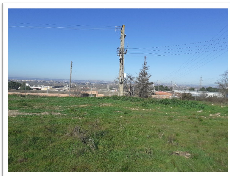
FOTOGRAFIA NÚM. 6. TRANSFORMADOR COMPANYIA ELÈCTRICA
