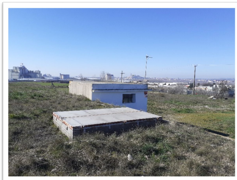
FOTOGRAFIA 2 DETALL ENTRADA COBERTA DIPÒSIT
