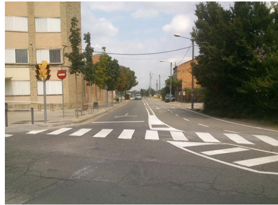
Foto 17 Carril bici Arquitecte Goma (sentit nord)
