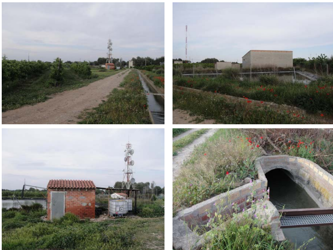
Imatge 30. Canals de reg, casetes de reg i altres infraestructures associades que es distribueixen pel Pla de les Torres. (abril, 2011)
