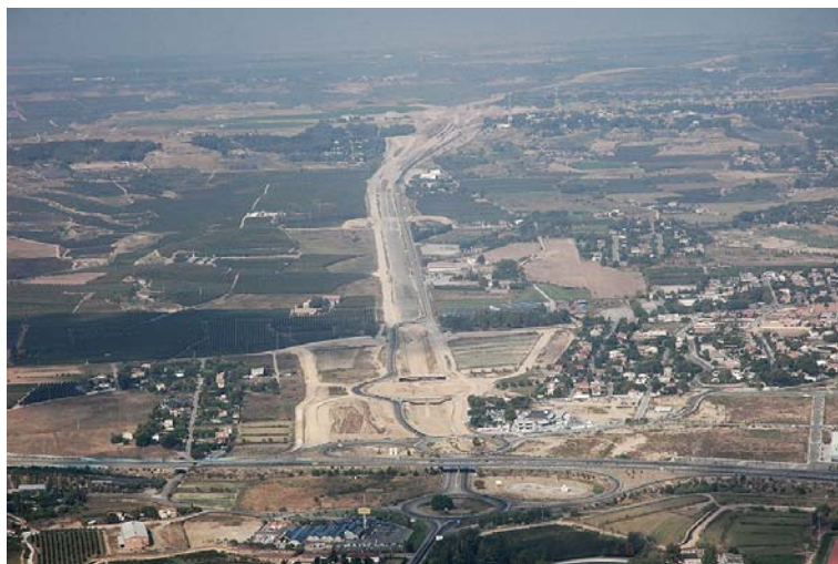
Imatge 7. Imatge de construcció de la nova A-22 (gener, 2009)
