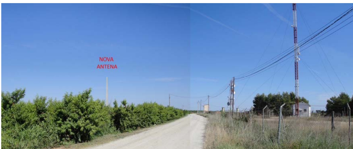
Emplaçament amb la torre de comunicacions objecte del PEU
