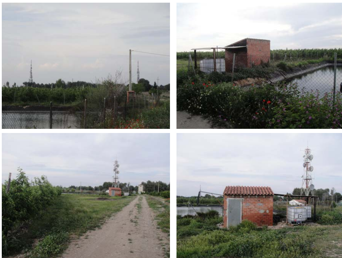
Imatge 11. Bassa de reg, escomesa elèctrica i infraestructures de reg: caseta de reg, dipòsits d'additius i subministrament d'aigua (abril, 2011).
