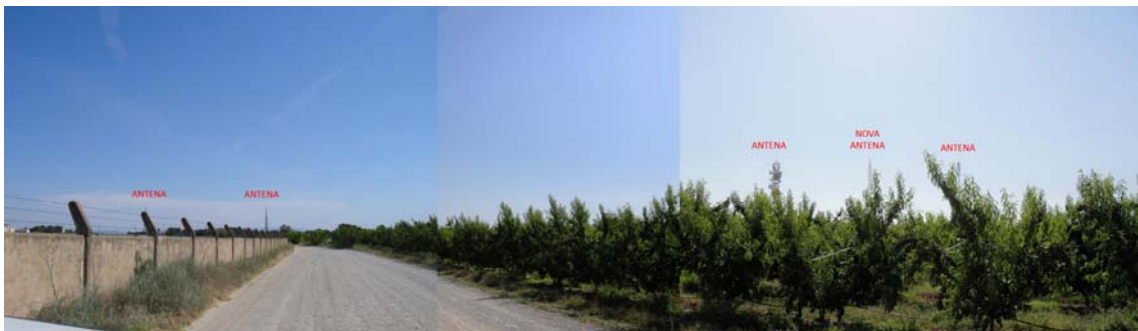
Emplaçament amb la torre de comunicacions objecte del PEU
