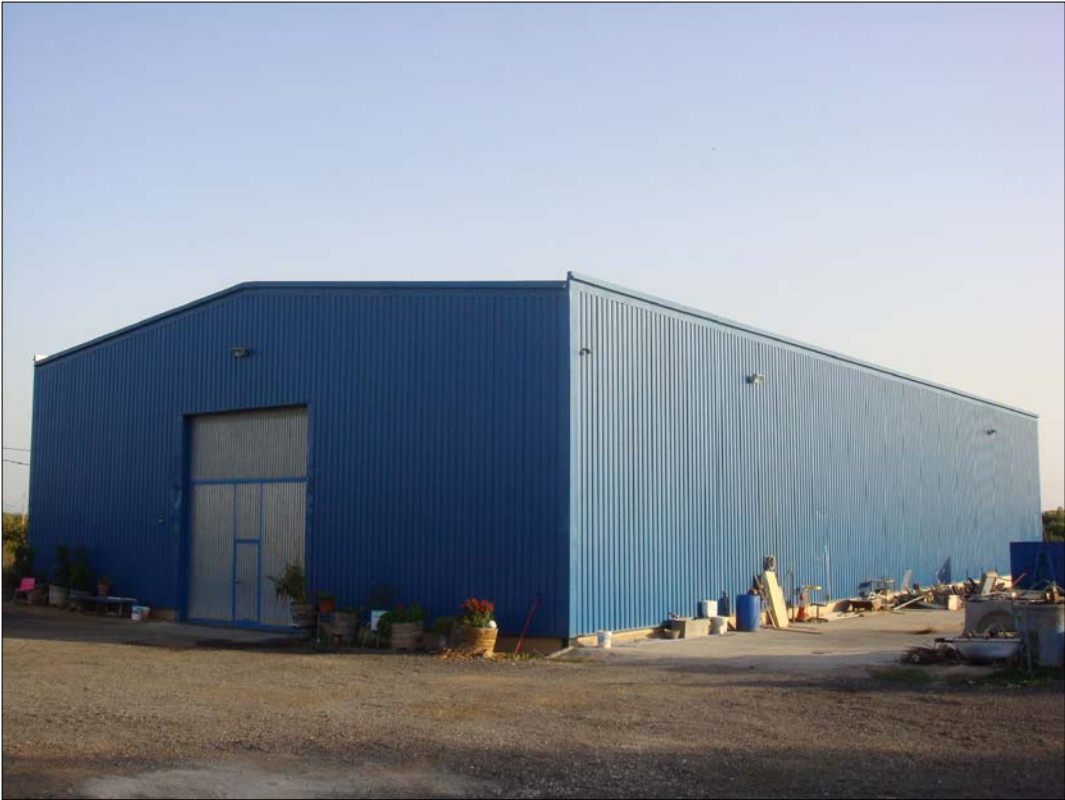
IMAGEN EXTERIOR NAVE
