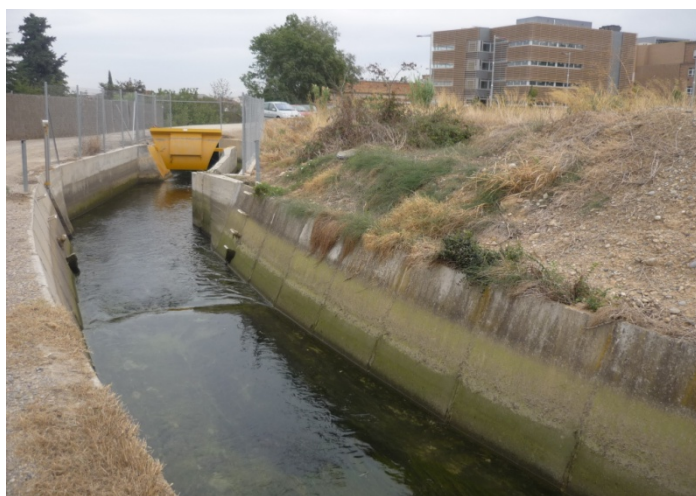
Foto 2. Vista de la sèquia de Pinyana que delimita l'àmbit pel nord, en una part a cel obert i en la resta, soterrada. Al fons s'aprecien les instal·lacions de l'Hospital Arnau de Vilanova.
