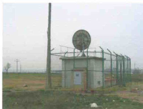
Imatge 9. Estructures annexes de control del oleoducte
