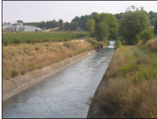
Vista del Canal d'Aragó i Catalunya
