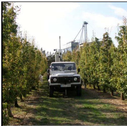
■ VISTAS DE LA ZONA RECONOCIDA : Emplazamiento sondeo S-1.
