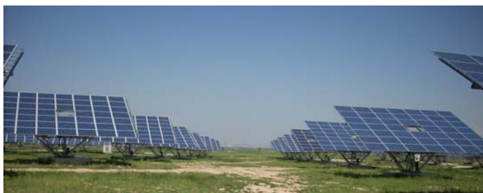
Fotografia Parc Solar de 1,3MW a Navarra amb seguidors Mecasolar
