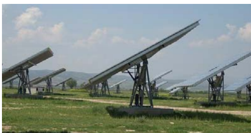
Fotografia Parc Solar de 1,3MW a Navarra amb seguidors Mecasolar
