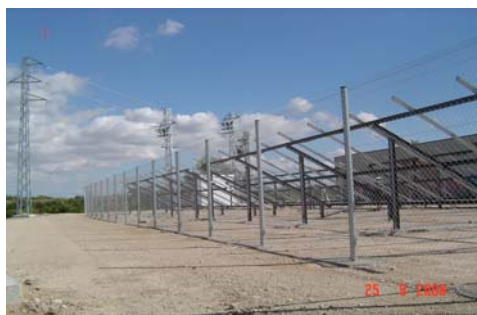
Imatge orientativa de la tanca perimetral
