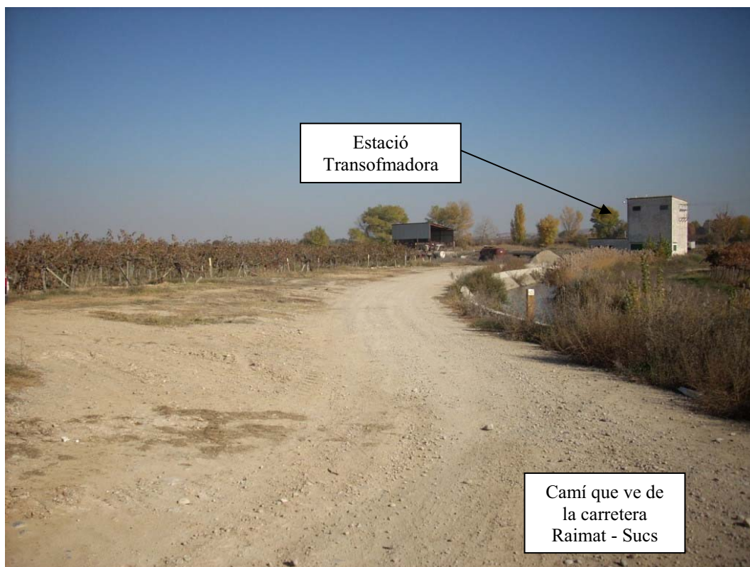
Fotografia n°6: Vista des de P3 en direcció Est. Vista de la ET i parcel·les veïnes.
