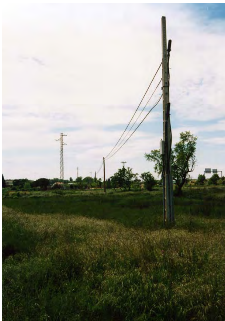
Infraestructures actuals. Línies elèctrica i telefònica aèries.
