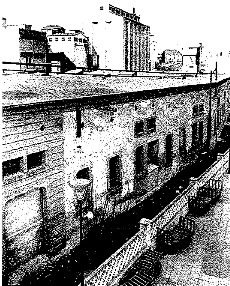
Façana des de les instal·lacions ferroviàries.
