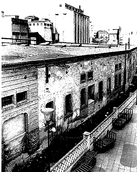
Façana des de les instal·lacions ferroviàries.
